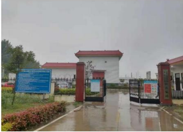
南阳市田洼泵站
