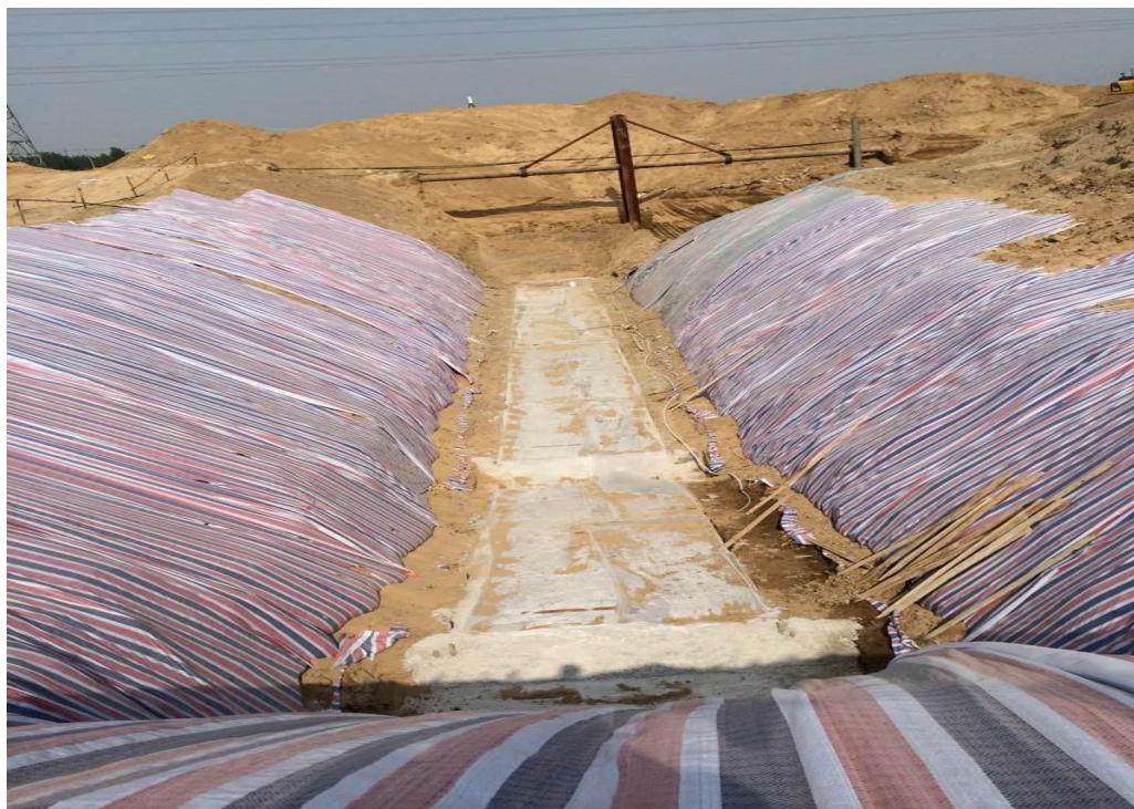
周口倒虹吸工程 沙南渠工程 彩虹布覆盖
