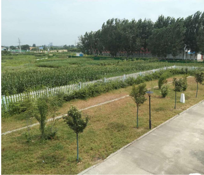
顶高泵站 平山庄生活 污水管道
