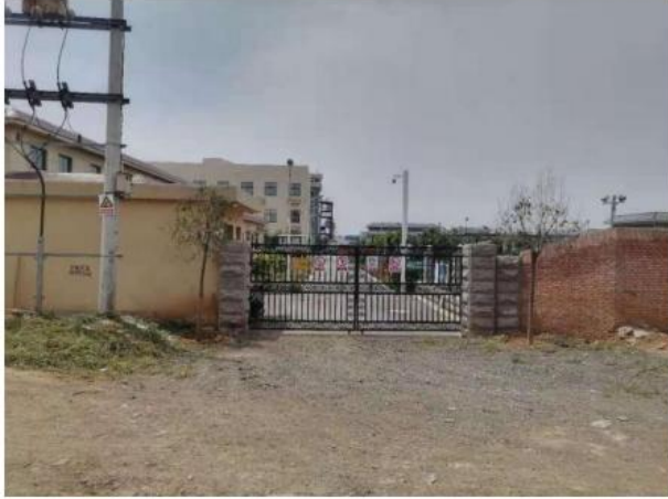
新乡市路固泵站
