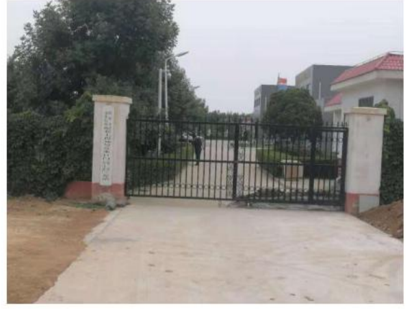
鹤壁市刘庄泵站
