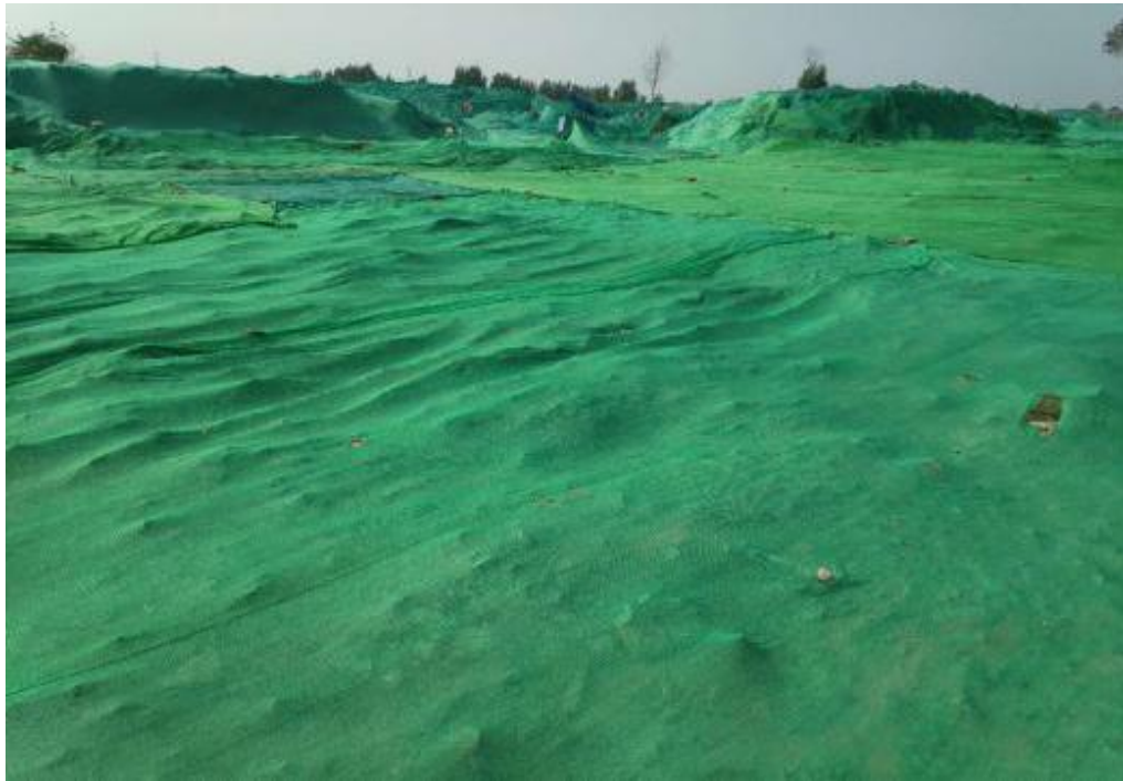
平山13号口施现扬处 理
