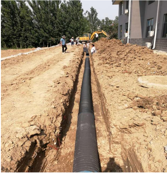
地埋式一体化生活污水处理设备施工
