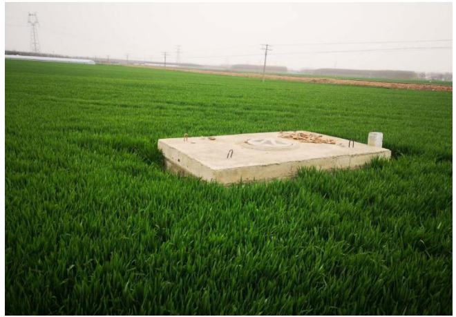
输水管线施工完成后复耕现状
