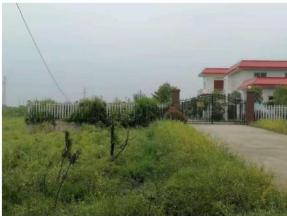
平顶山市宝丰县高庄泵站
