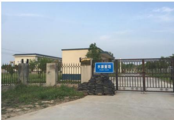
荥阳市前蒋寨泵站
