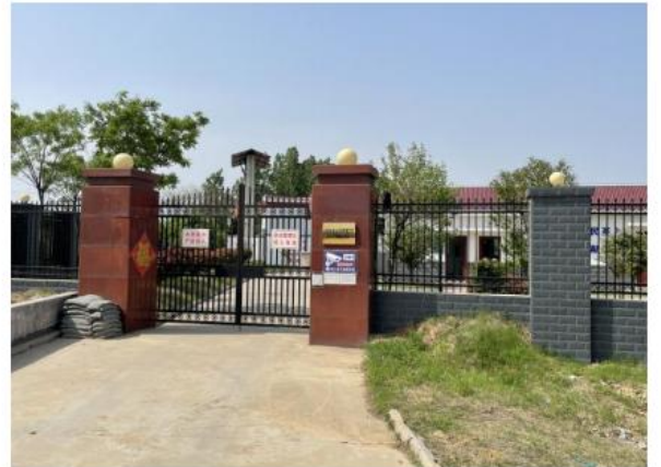
安阳市董庄泵站
