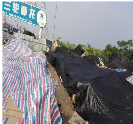
施工现场物料覆盖
