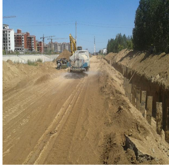
施工区域洒水降尘
