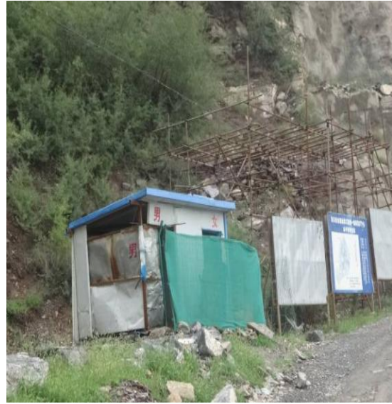
施工现场临时厕所
