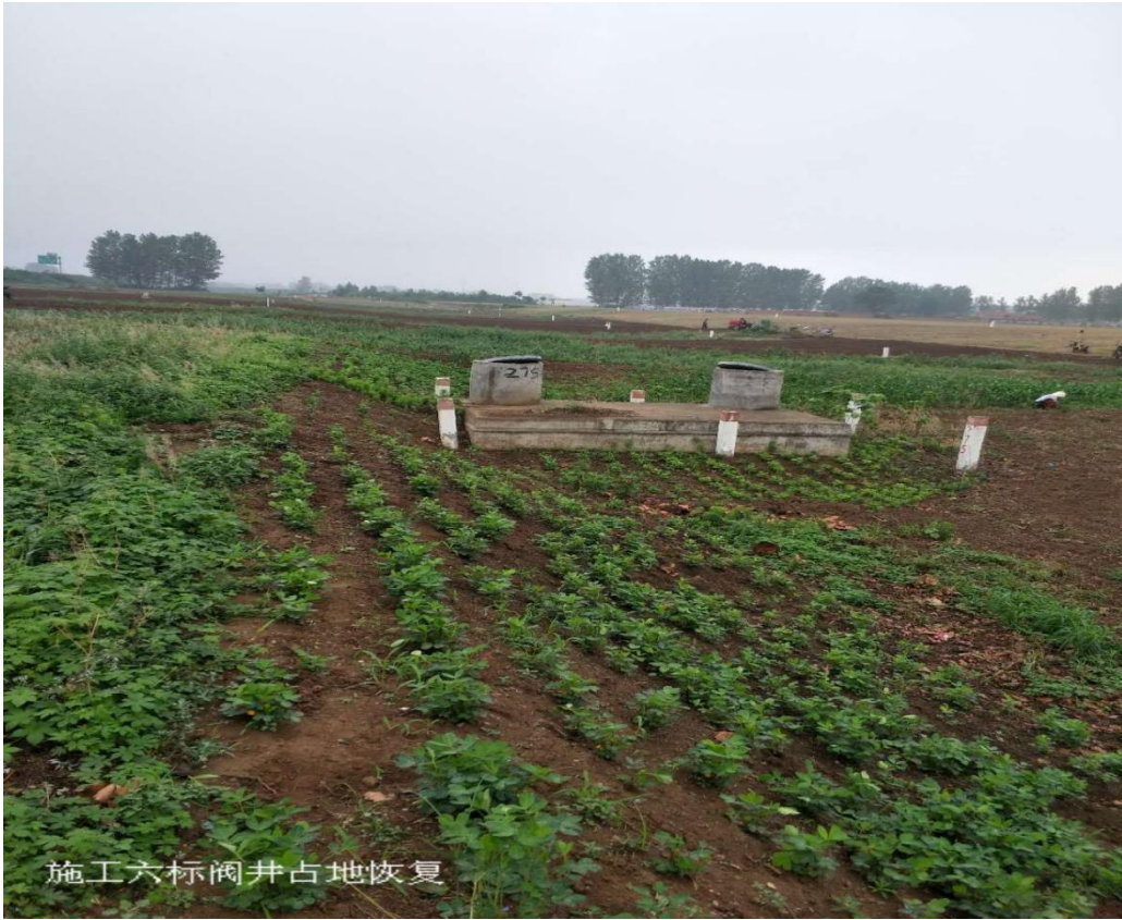
周口市施工 6 标阀井占地恢复
