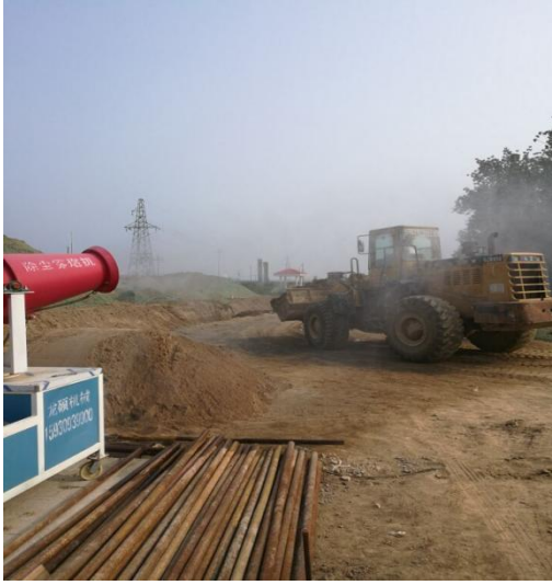
施工场内防尘雾炮机喷雾防尘
