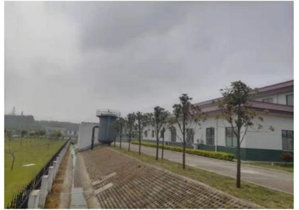
南阳市方城县十里庙泵站
