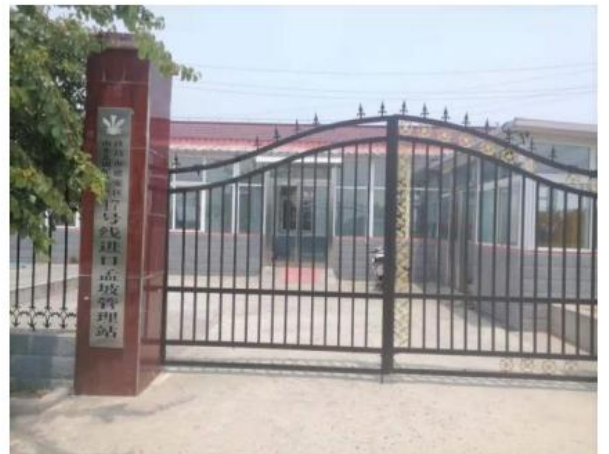
许昌禹州市孟坡泵站
