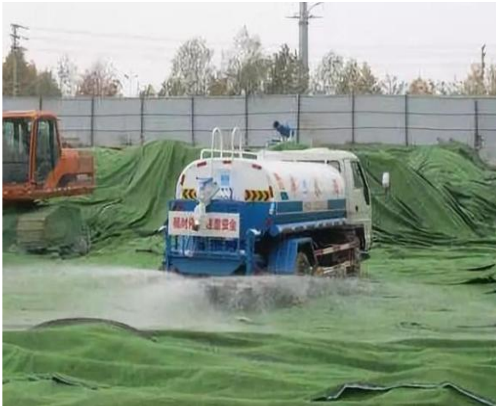
施工场内防尘雾炮机喷雾防尘
