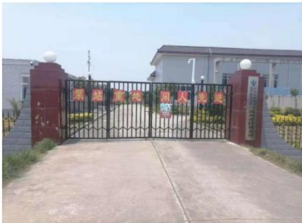
许昌市任坡泵站
