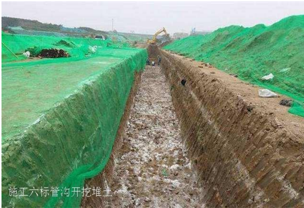
周 口 施 工 6 标 管 沟 开 挖
